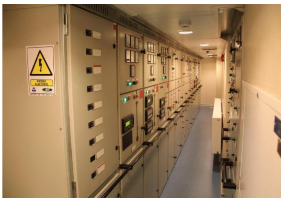
Rafmagnstafla um borð í varðskipinu Þór.
